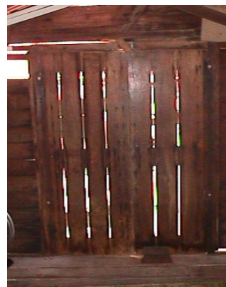
Figure 32(a): Loosen door
